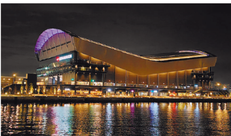
ジューライオンアリーナ神戸 神戸港に誕生したアリーナ。1万人収容でスポーツや音楽イベントに対応。海に囲まれた絶景ロケーション。
