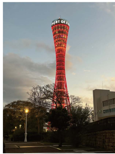
神戸ポートタワー（日建設計工務 1963）
